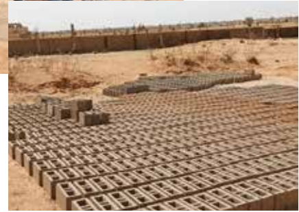
Die Ziegel werden vor Ort gebrannt
